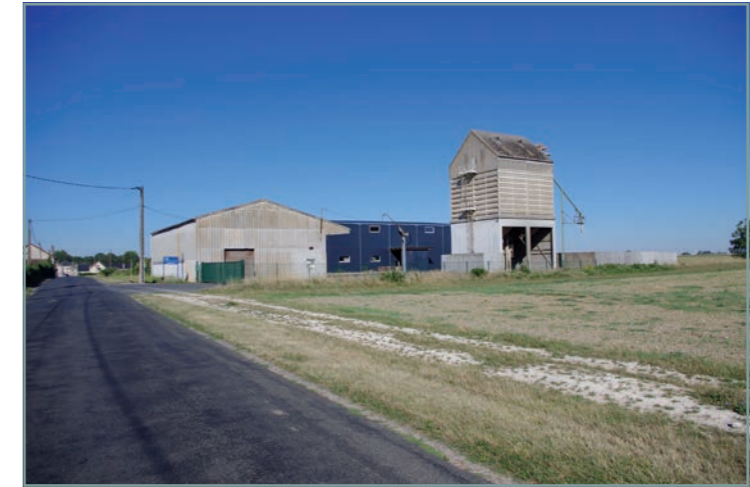
FIGURE 15: Silos et Hangars à Sceaux-du-Gâtinais
